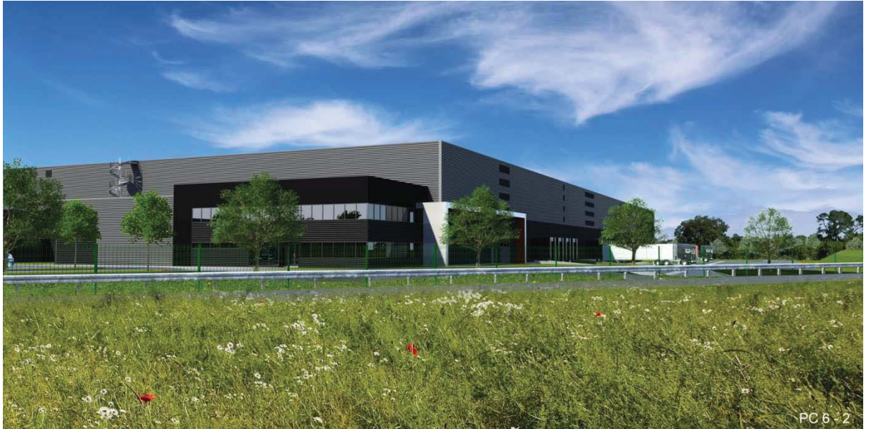
Vue depuis l'angle sud-ouest (les bureaux/locaux sociaux et locaux techniques sont au premier plan)
